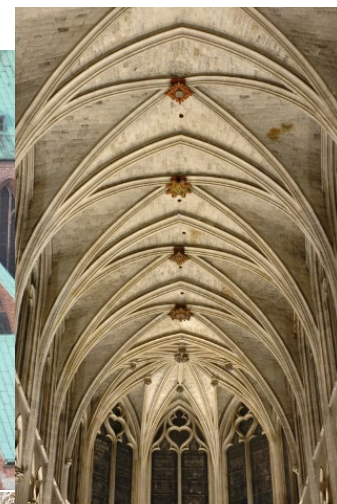
bóveda de crucería
